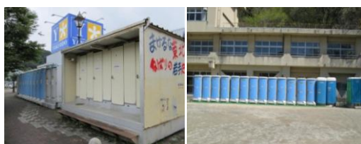
写真-11 避難所の仮設トイレ (釜石市)
