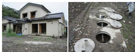
写真-14 被災家屋と浄化槽 (釜石市)
