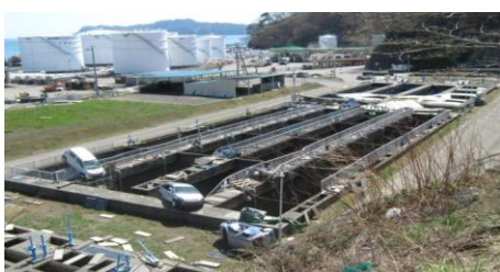
写真－5 下水道処理施設の被災状況 (釜石市)
