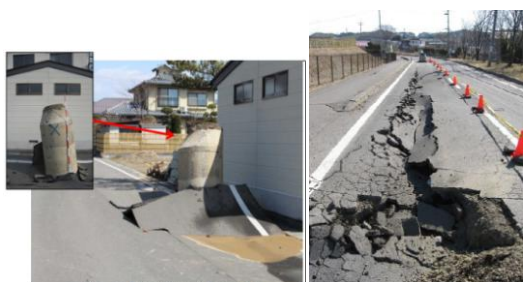
写真－5 下水道処理施設の被災状況 (釜石市)
