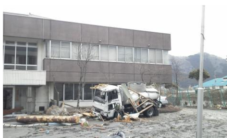
写真－4 し尿処理施設の被災状況 (気仙広域連合 衛生センター)
