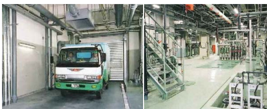
写真-8 搬入の様子と施設内部
