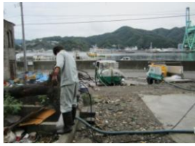
写真-15 残渣物の引抜き
