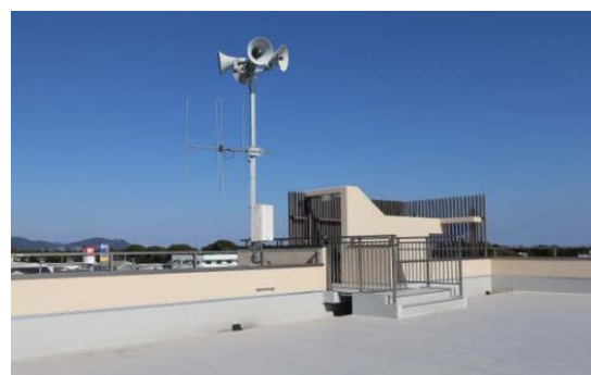
写真-17 屋上を避難所とした例 (熊野市 クリーンセンター)
