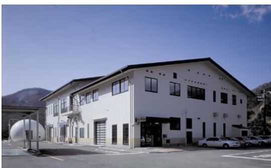
写真-1 汚泥再生処理センター
