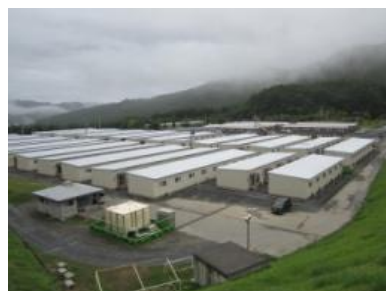
写真-12 仮設住宅の様子 (釜石市)
