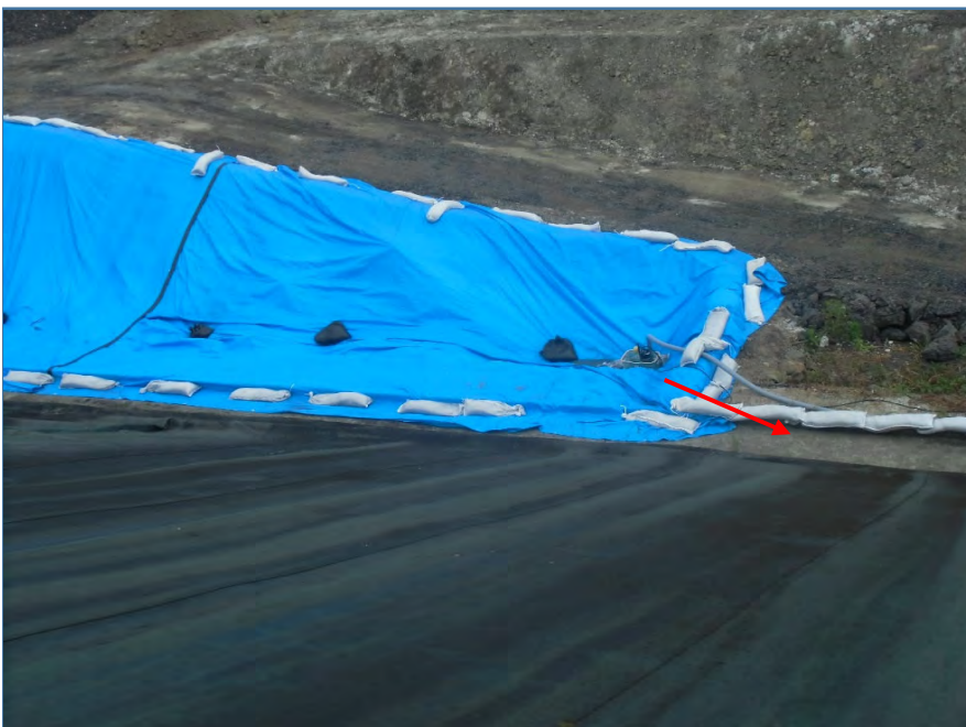
埋立地内雨水排水対策 南側搬入スロープより二期埋立 地へ水中ポンプで排水
